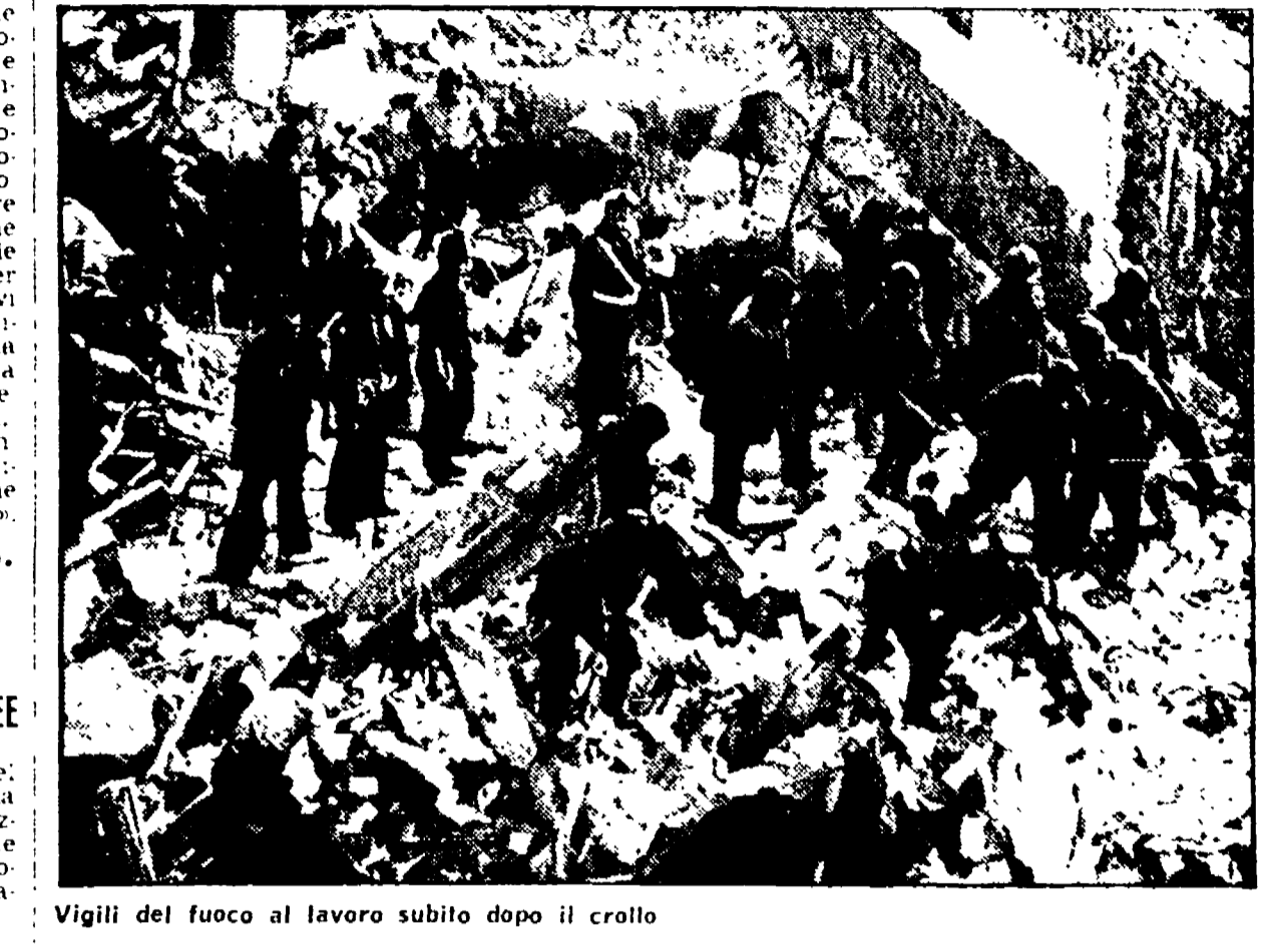
Vigili del fuoco al lavoro subito dopo il crollo
