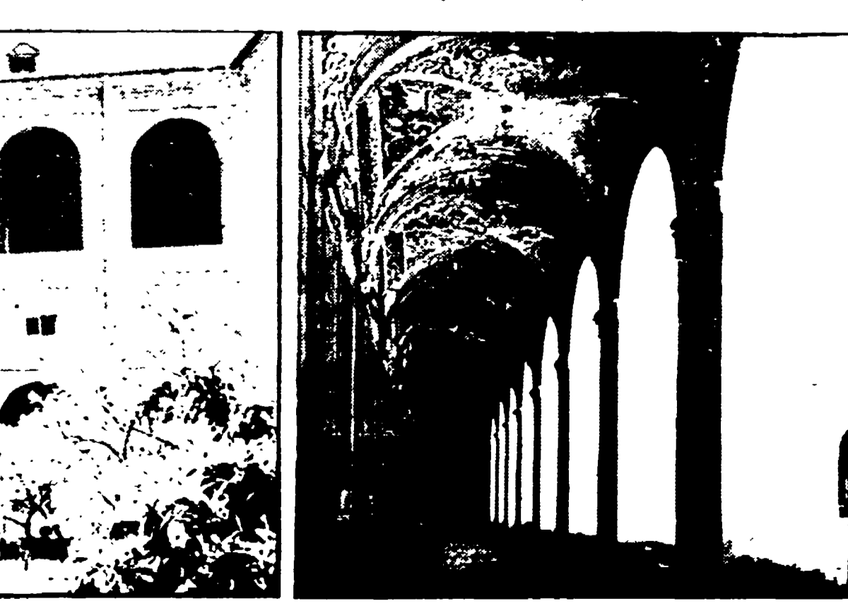
Nella foto accanto al titolo la capriata centrale del S. Michele a restauro ultimato. Nelle due foto in basso: il chiostro degli aranci e a destra, decorazioni e stucchi che ornano le volte dei portici.
