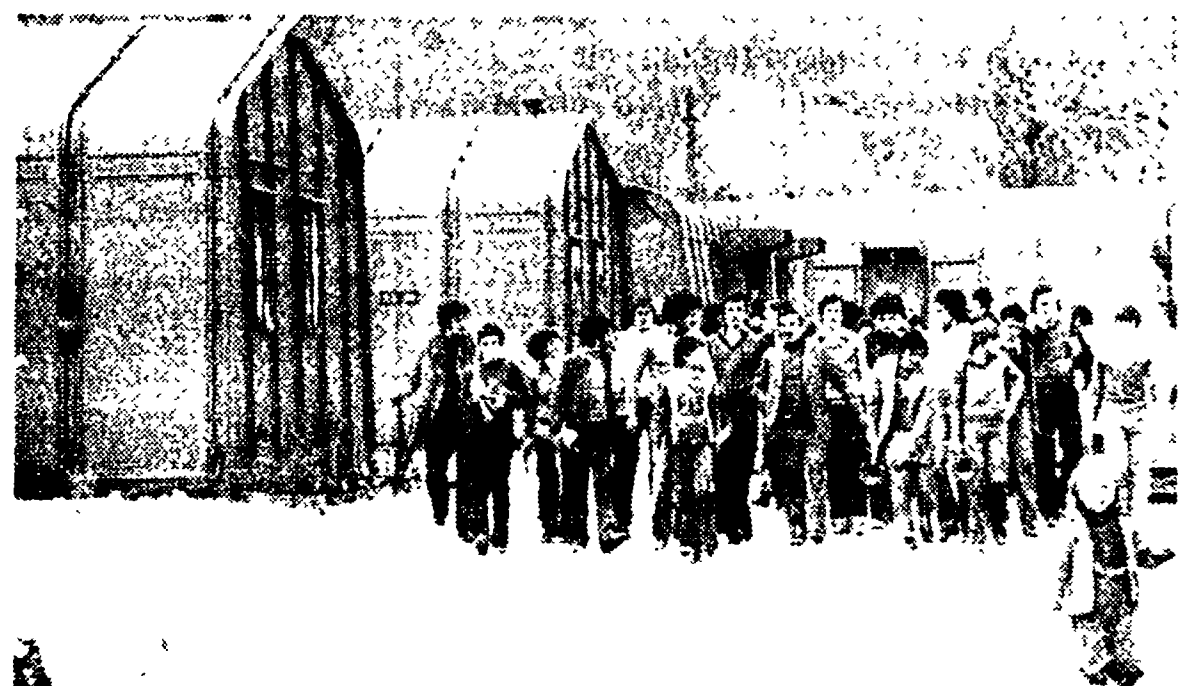
NELLA FOTO: alcuni prefabbricati del «Villaggio Liguria».
