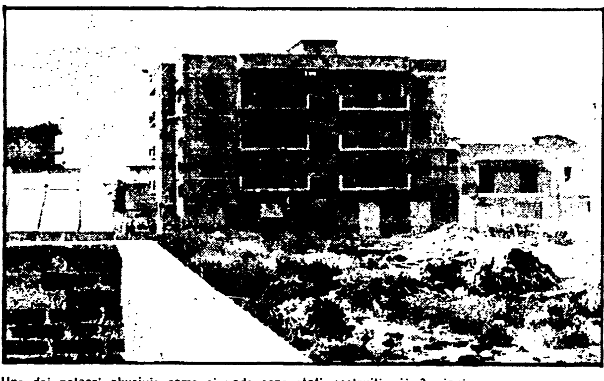
Uno dei palazzi abusivi: come si vede sono stati costruiti già 3 piani
