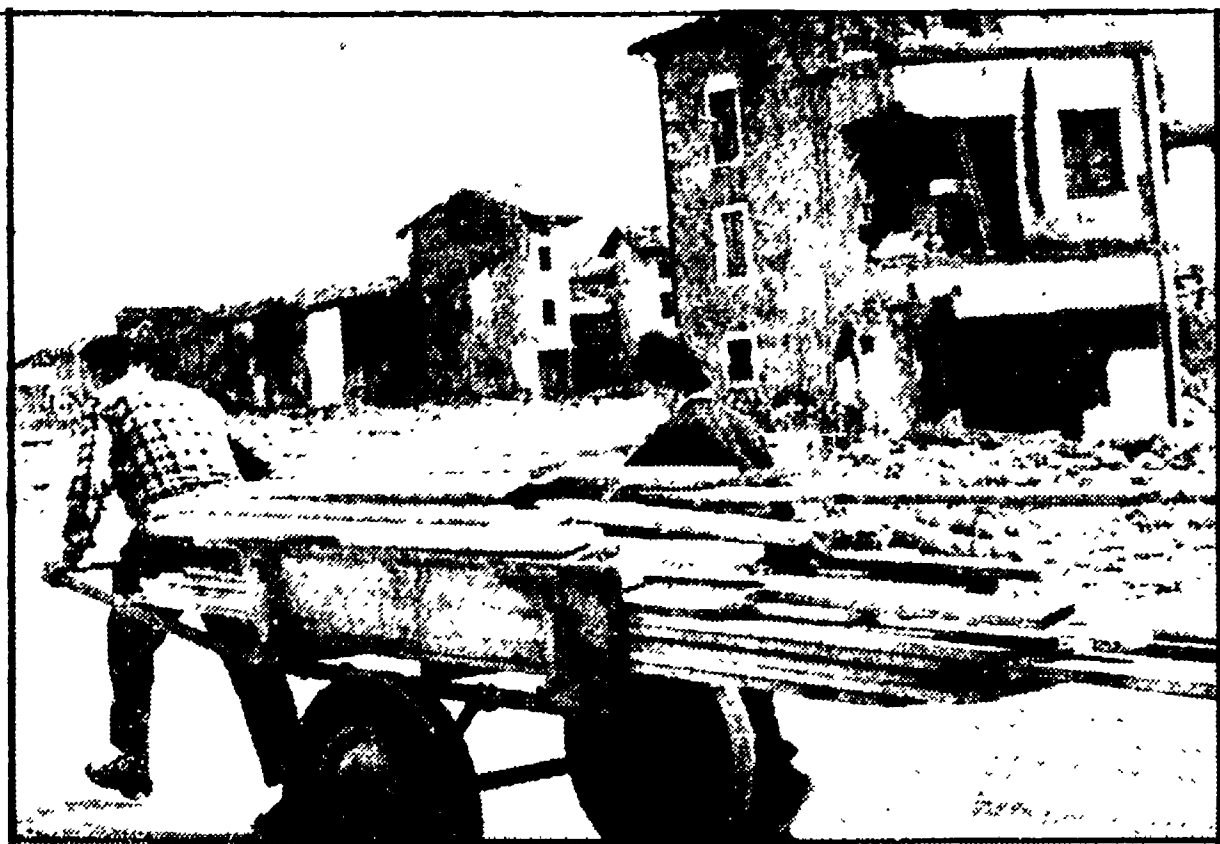
OSOPPO — Padre e figlio impegnati nei lavori di ricostruzione
