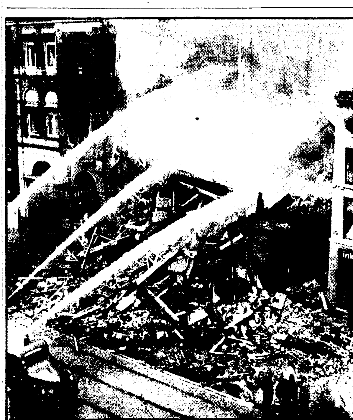
AMSTERDAM - L'hotel Polen quasi completamente distrutto dal violento incendio
