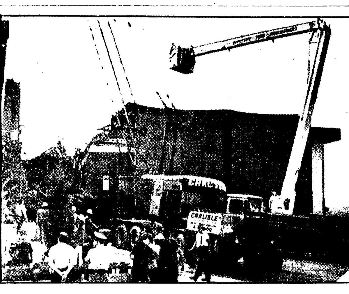
170 I MORTI NEL «NIGHT» Si continua a scavare fra le macerie del super-night distrutto da un gigantesco incendio che ha provocato la morte di almeno 170 persone...
