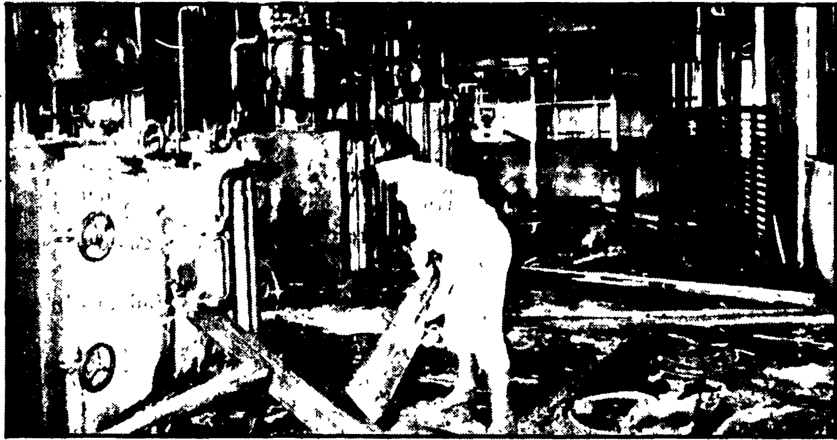
MILANO — L'interno, completamente distrutto, della fabbrica chimica dove è avvenuta l'esplosione
