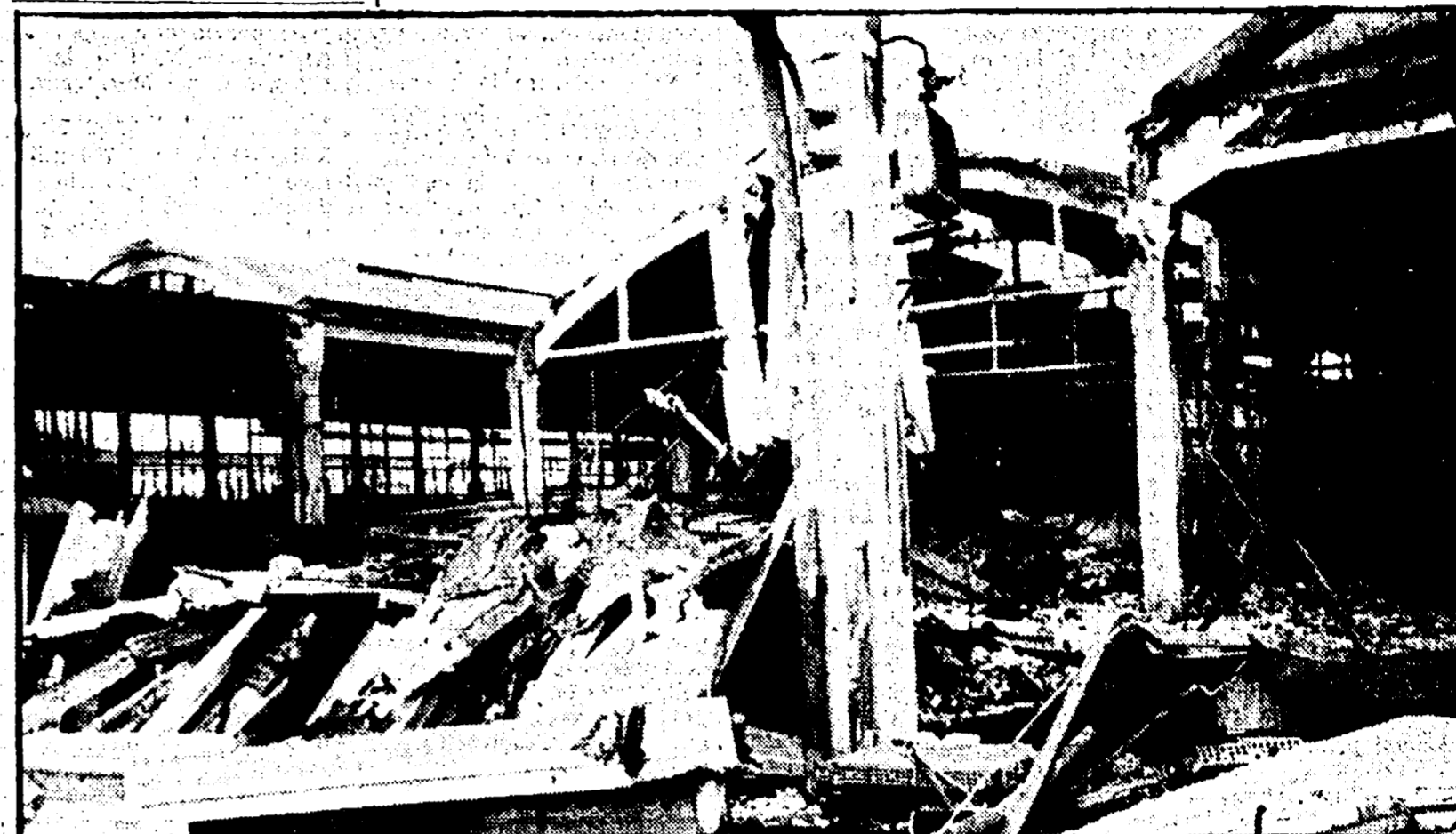
MILANO — I capannoni della Magneti Marelli completamente distrutti dalle fiamme
