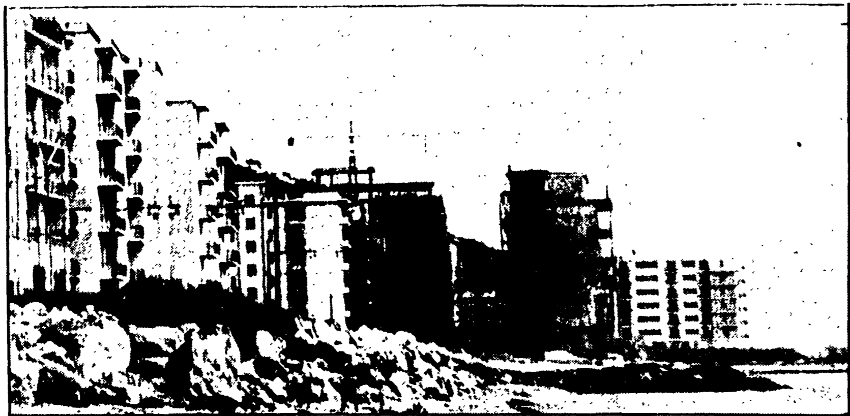
LOANO - Un fronte di cemento sulla spiaggia: una situazione quasi senza interruzione tra la Lunigiana e la Costa Azzurra
