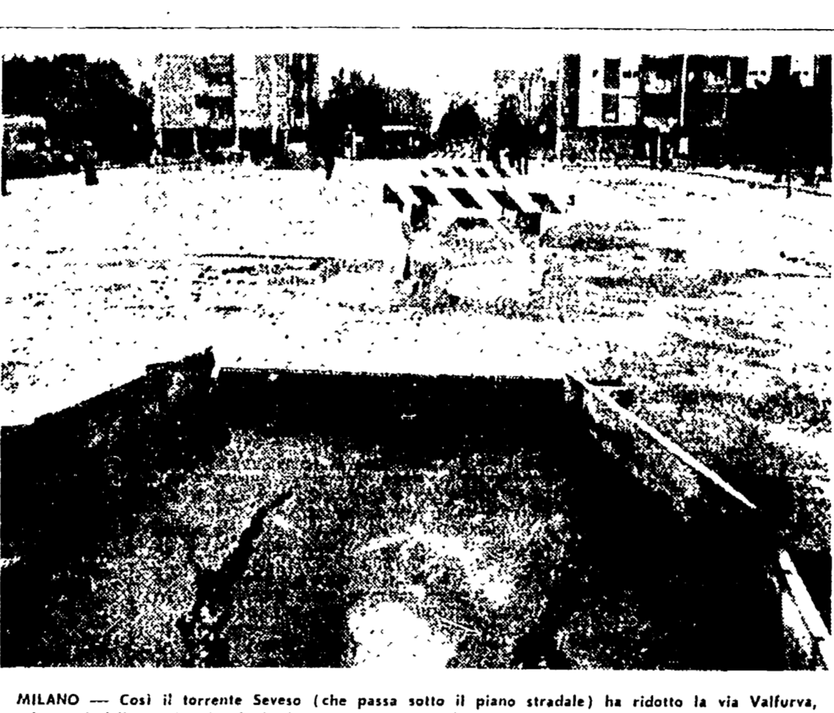
MILANO - Così il torrente Seveso (che passa sotto il piano stradale) ha ridotto la via Valfurva, nei pressi della piscina Scaroni, dopo gli accozzamenti dei giorni scorsi.
