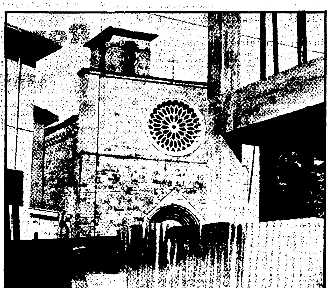
LA CHIESA SOFFOCATA DAL CEMENTO Tra una chiesa romana del 1200 e un palazzo di cui si ignora la destinazione. La costruzione soffoca già visibilmente i due monumenti. La licenza rilasciata dal Comune parla di ristrutturazione di un gruppo di edifici, ma il proprietario dell'area — Eligio Jezzoni, il noto concessionario d'auto romano — non sta ristrutturando un bel niente, sta solo costruendo una sala da lettura, la passiamo alla autorità competente. NELLA FOTO : la chiesa romanica e, in primo piano, i piloni del palazzo nuovo.
