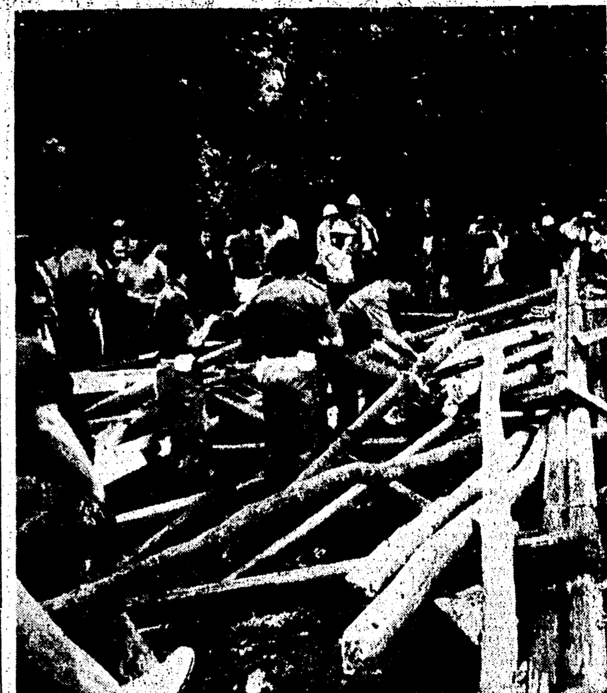
MONZA - Soldati al lavoro tra l'impalcatura che reggeva l'insegna pubblicitaria il cui crollo ha provocato una vittima e parecchi feriti.
