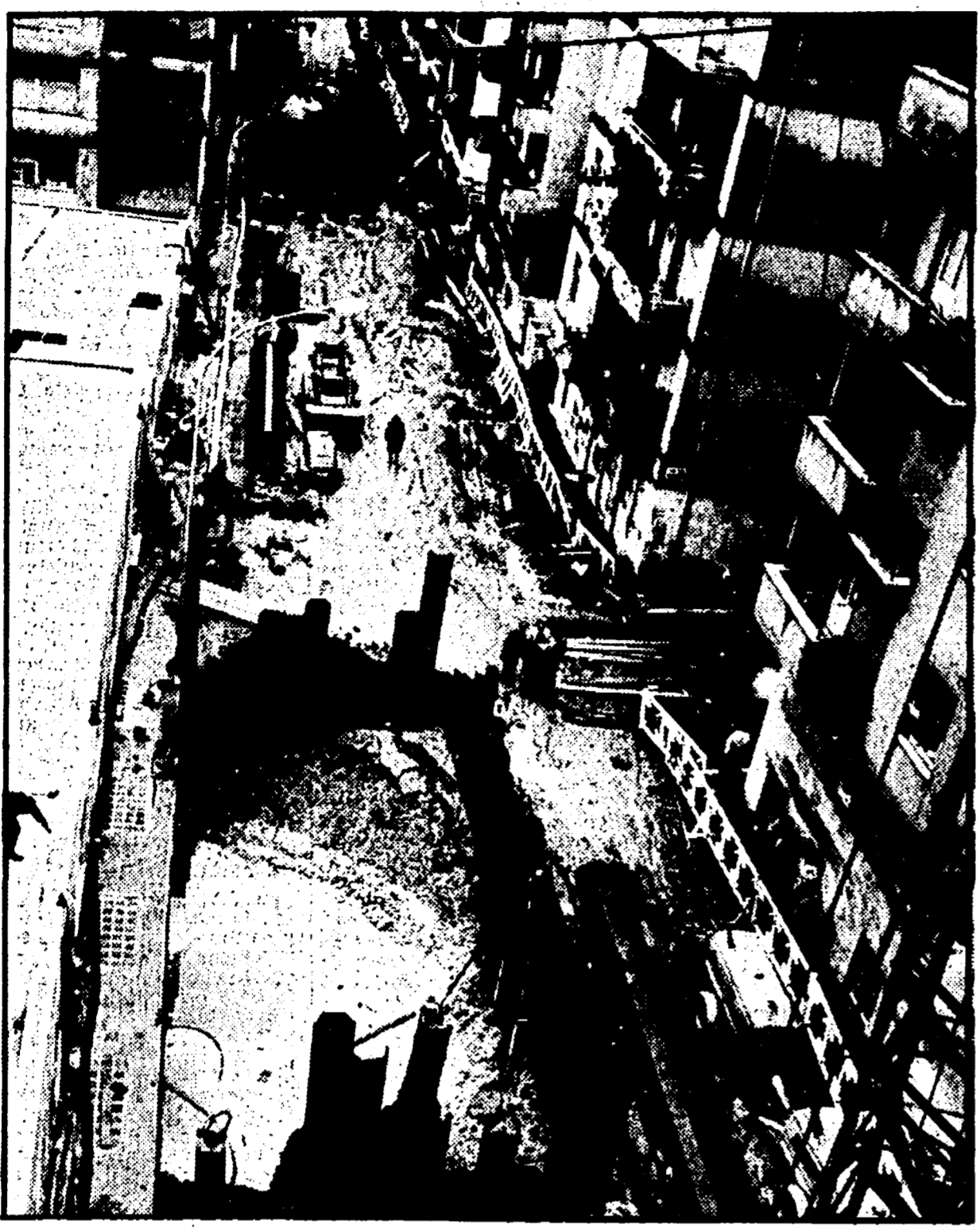
Le due voragini in via della Balduina transennate per impedire l'erosione
