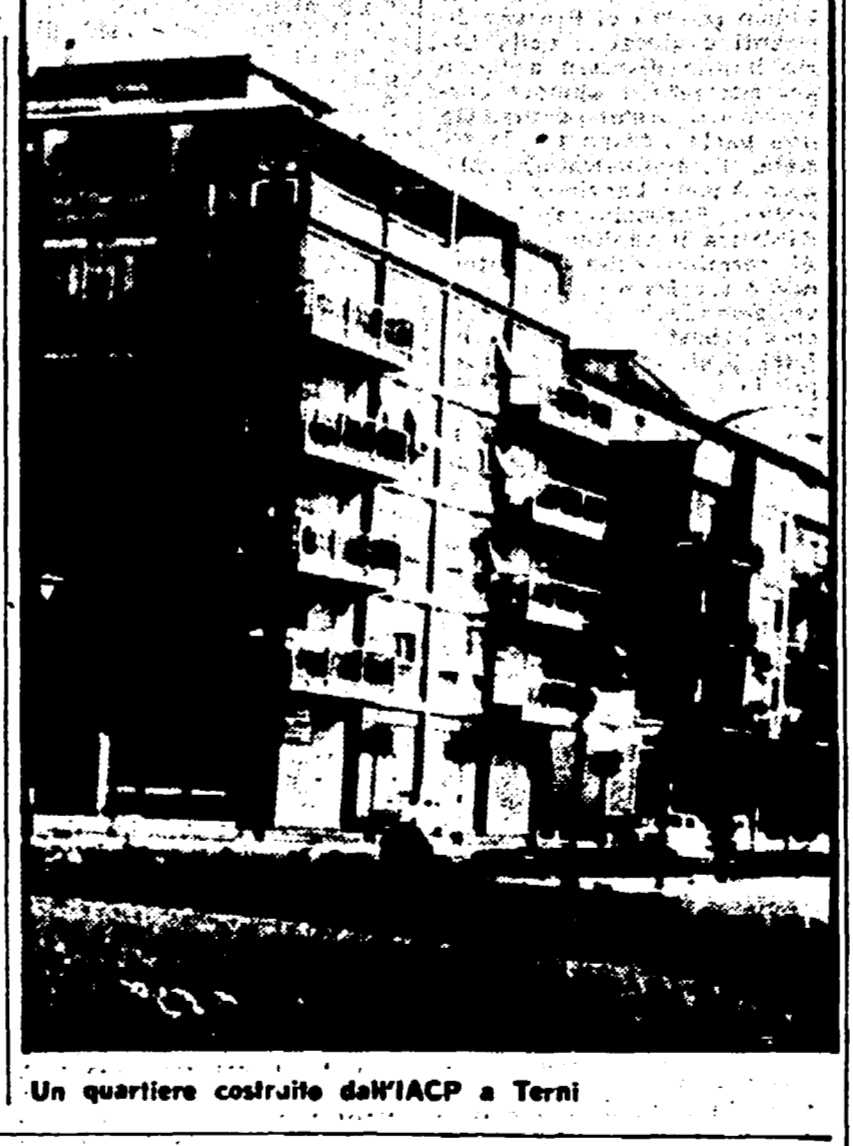
Un quartiere costruito dall'IACP a Terni
