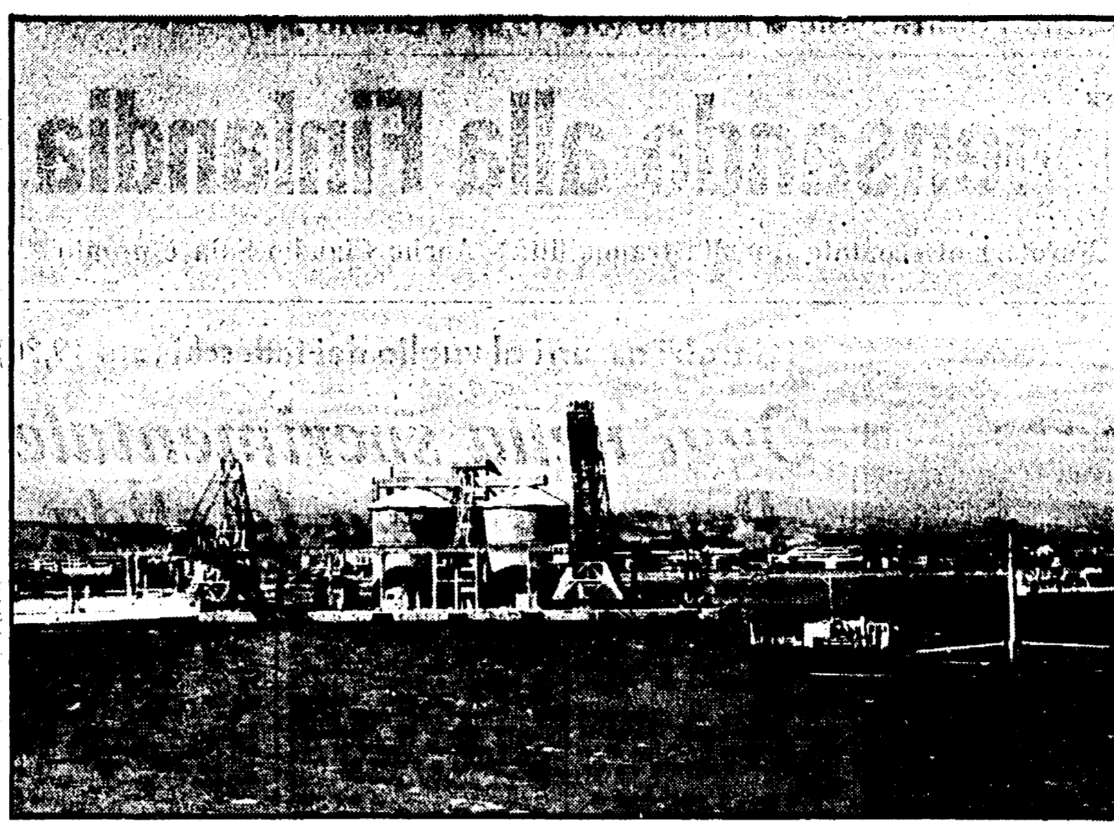
Gli impianti e il silos per lo scarico della fosforite alla Montedison di Crotona
