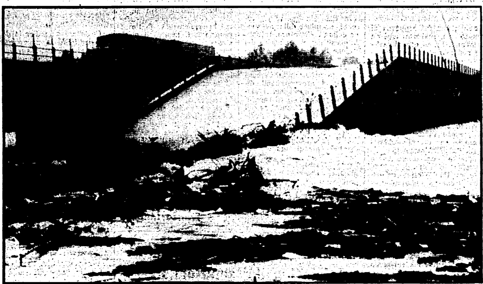
TORINO — Il ponte sull'autostrada Torino-Milano, nei pressi di Brandizzo, crollato per la piena del fiume Orco
