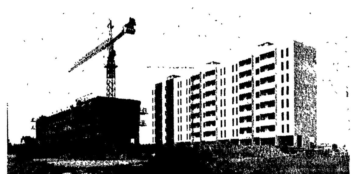
Due edifici in prefabbricato costruiti per la Coop. edificatrici «La Valeria» e «Abicopa» di Reggio E.
