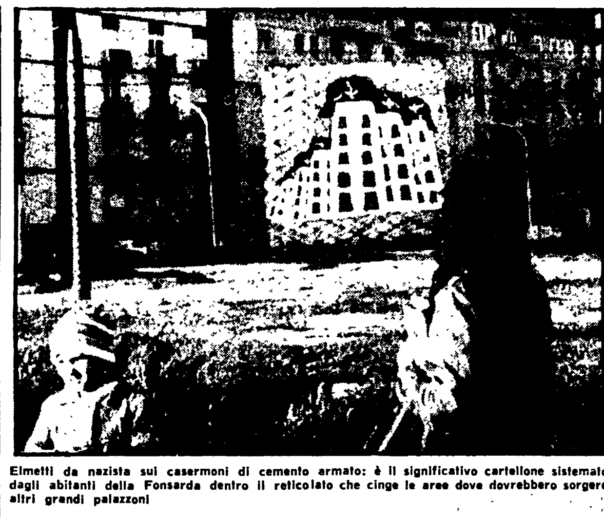
Elementi da nazista sui casermoni di cemento armato: è il significativo cartellone sistemato dagli abitanti della Fonsarda dentro il reticolato che cinge le aree dove dovrebbero sorgere altri grandi palazzoni
