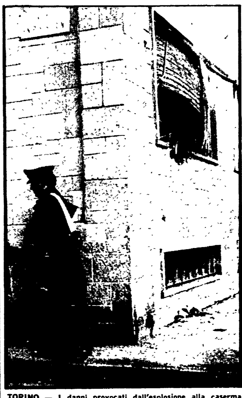
TORINO — I danni provocati dall'esplosione alla caserma dei CC a seguito dell'attentato rivendicato da «Prima linea»
