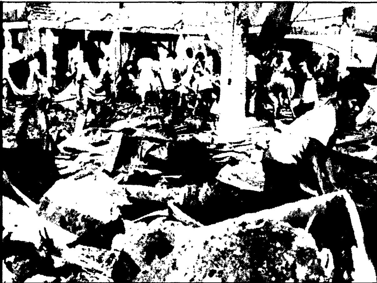
MANAGUA - Si scava fra le macerie di un edificio a Rivas fatto saltare in aria dai guerriglieri in una delle loro azioni contro il regime di Somoza
