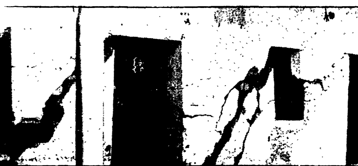
Una casa lesionata irrimediabilmente dall'alluvione
