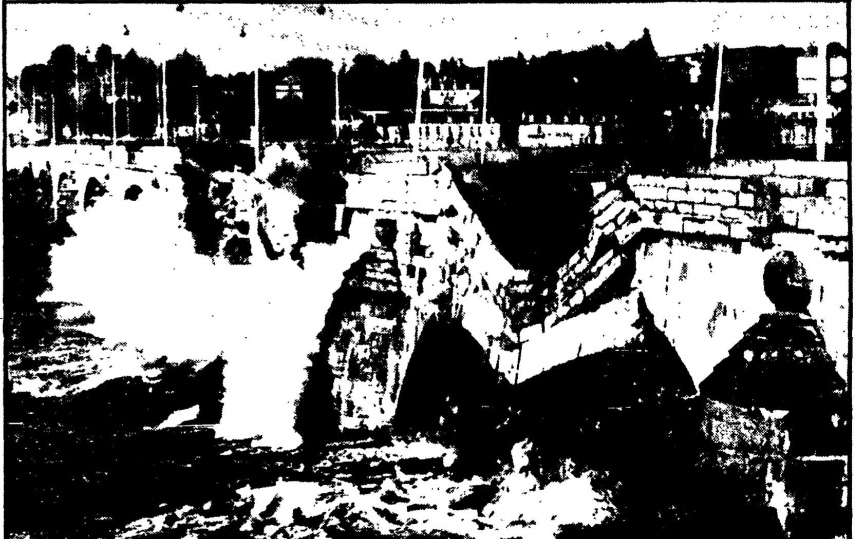
CROLLATO UN PONTE SULLA LOIRA — Più della metà della popolazione di Tours 400 mila abitanti — resterà priva d'acqua potabile fino a giovedì a causa del crollo di tre delle quindici arcate del massiccio ponte Wilson sulla Loira, attraverso il quale, oltre al traffico della strada statale numero 10, passano numerosi condotti d'acqua. Il vecchio ponte Wilson, cominciato nel cadimento di un pilone bombardato durante l'ultima guerra e ricostruito nel 1945, non ha provocato vittime. Nel momento in cui la massiccia cominciata a squarciarsi transitava sul ponte una sola automobile: accelerando bruscamente, il conducente è riuscito a superare la crepa che si stava allargando. Nella foto: il ponte crollato.
