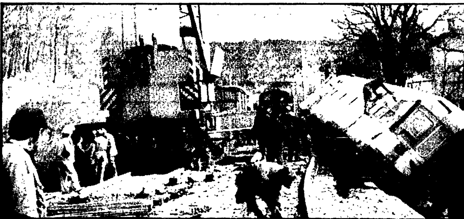
MONZUNO — Operai al lavoro per il ripristino della linea ferroviaria
