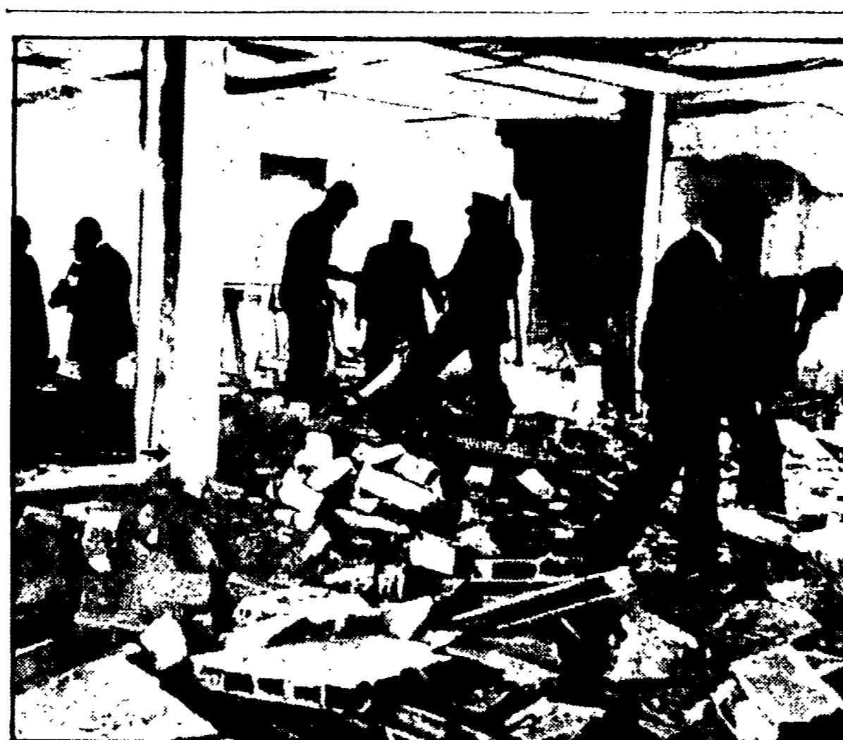
TORINO - L'interno della caserma del CC in costruzione a Grugliasco completamente devastata dall'esplosione
