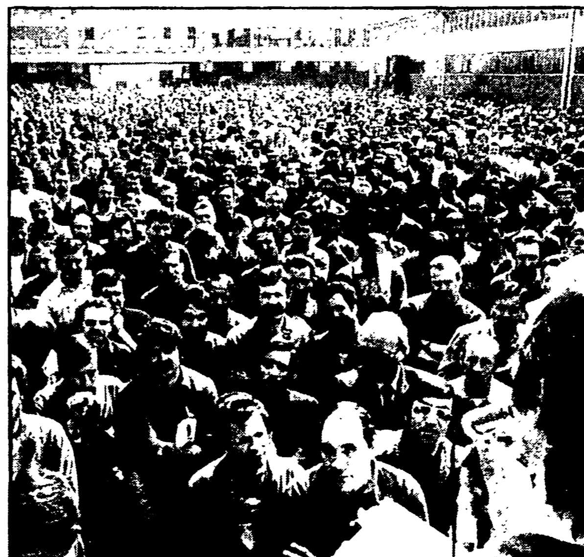
MILANO - L'assemblea dei lavoratori dell'Alfa di Arese nel cortile dello stabilimento
