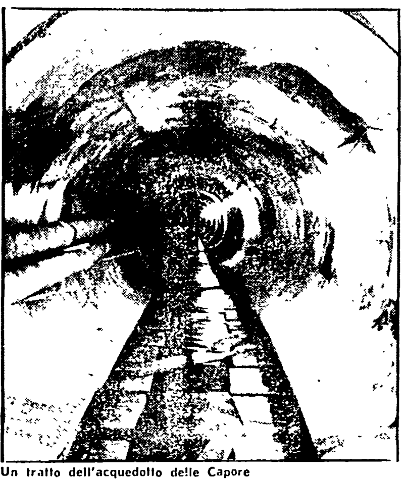
Un tratto dell'acquedotto delle Capore
