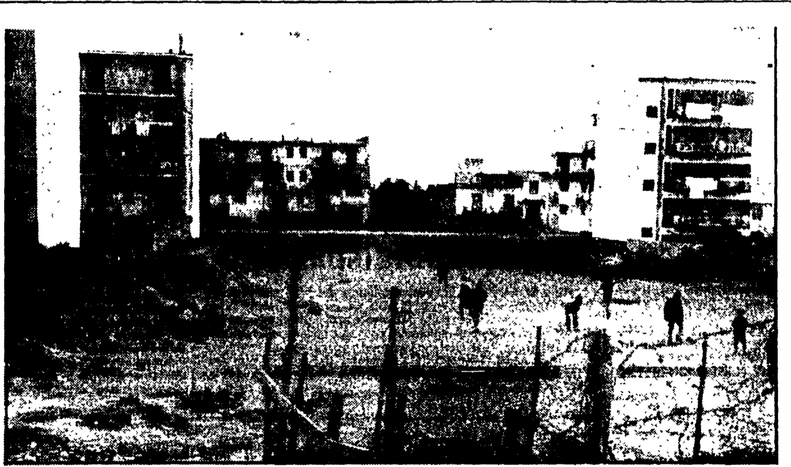
Da Napoli a Pianura, dove si muove nei cantieri abusivi
