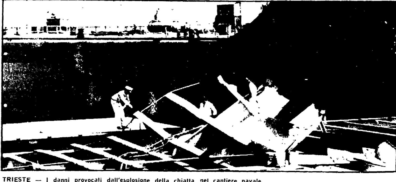
TRIESTE - I danni provocati dall'esplosione della chiatta nel cantiere navale
