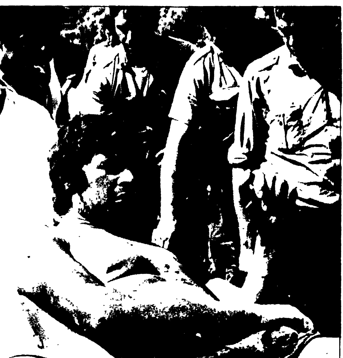
SEPOLTO DA UNA FRANA. Un operaio di S. Anna, Enzo Rapaci, è stato sepolto da una frana prodotta dal terreno friabile, durante i lavori di scavo per una rete fognaria a Lungoreve delle Vigne. L'incidente sul lavoro è avvenuto nel pomeriggio del 14/70 davanti agli occhi di altri commoati. Il tempo di intervento dei soccorsi fu di poche ore. La causa è stata un cedimento del terreno, che ha provocato la morte di un operaio e la ferita di altri due. Le altre frane si produrranno, man mano che si scava.
