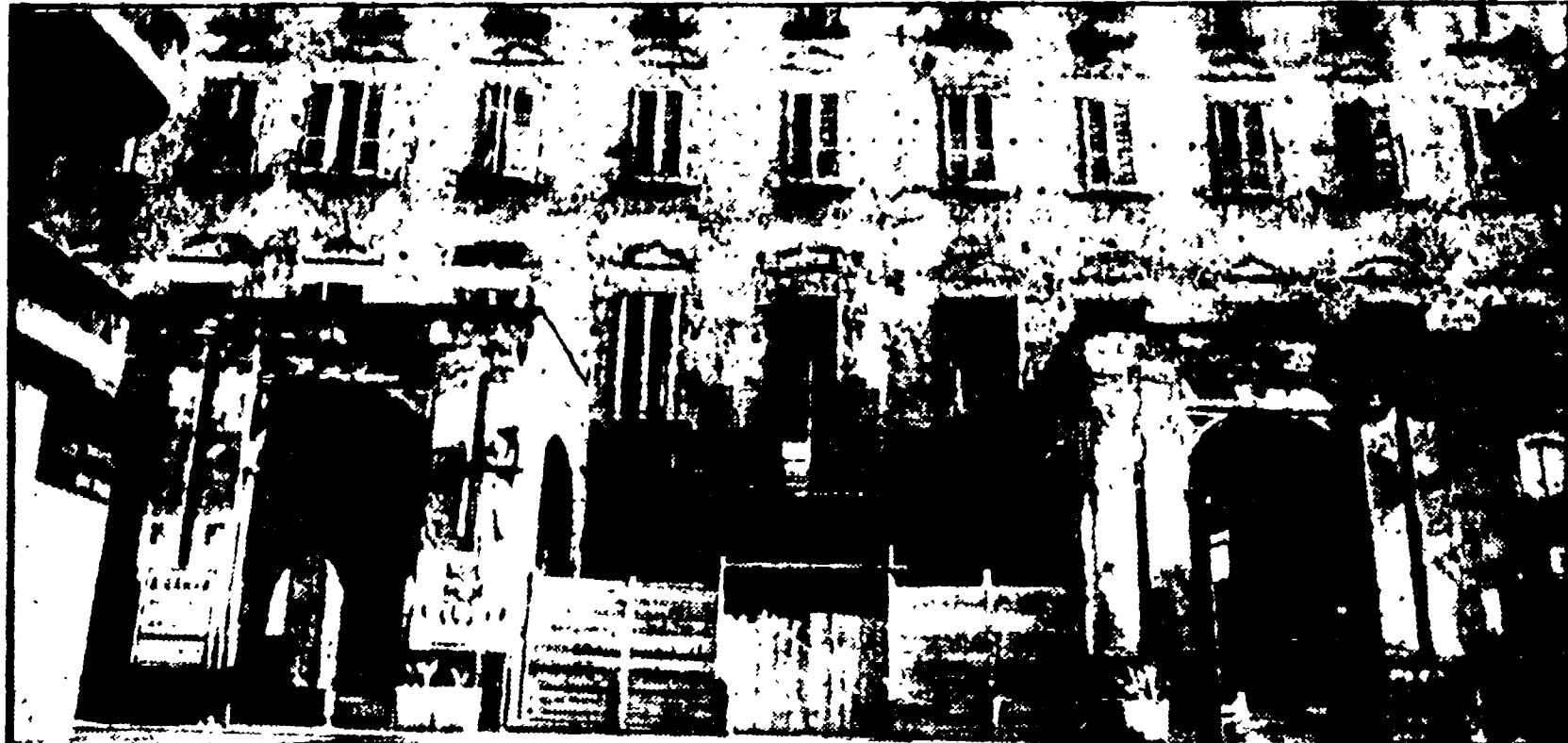
Dopo quattordici anni inizia finalmente il restauro conservativo per Palazzo Roccella, la cui vicenda coincide con la storia della rapina edilizia
