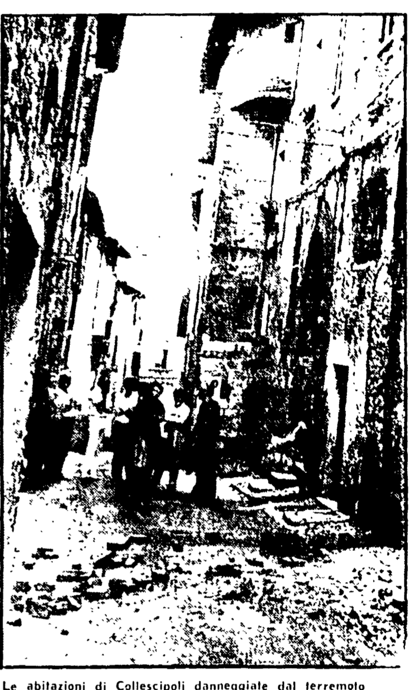
Le abitazioni di Collescipoli danneggiate dal terremoto
