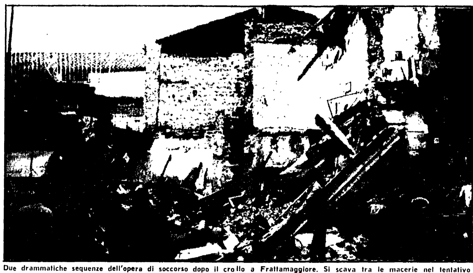
Due drammatiche sequenze dell'opera di soccorso dopo il crollo a Frattamaggiore. Si scava tra le macerie nel tentativo di salvare Francesca Tramontano
