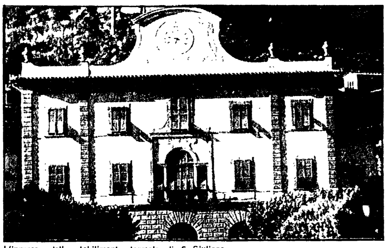
L'ingresso dello stabilimento termale di S. Giuliano
