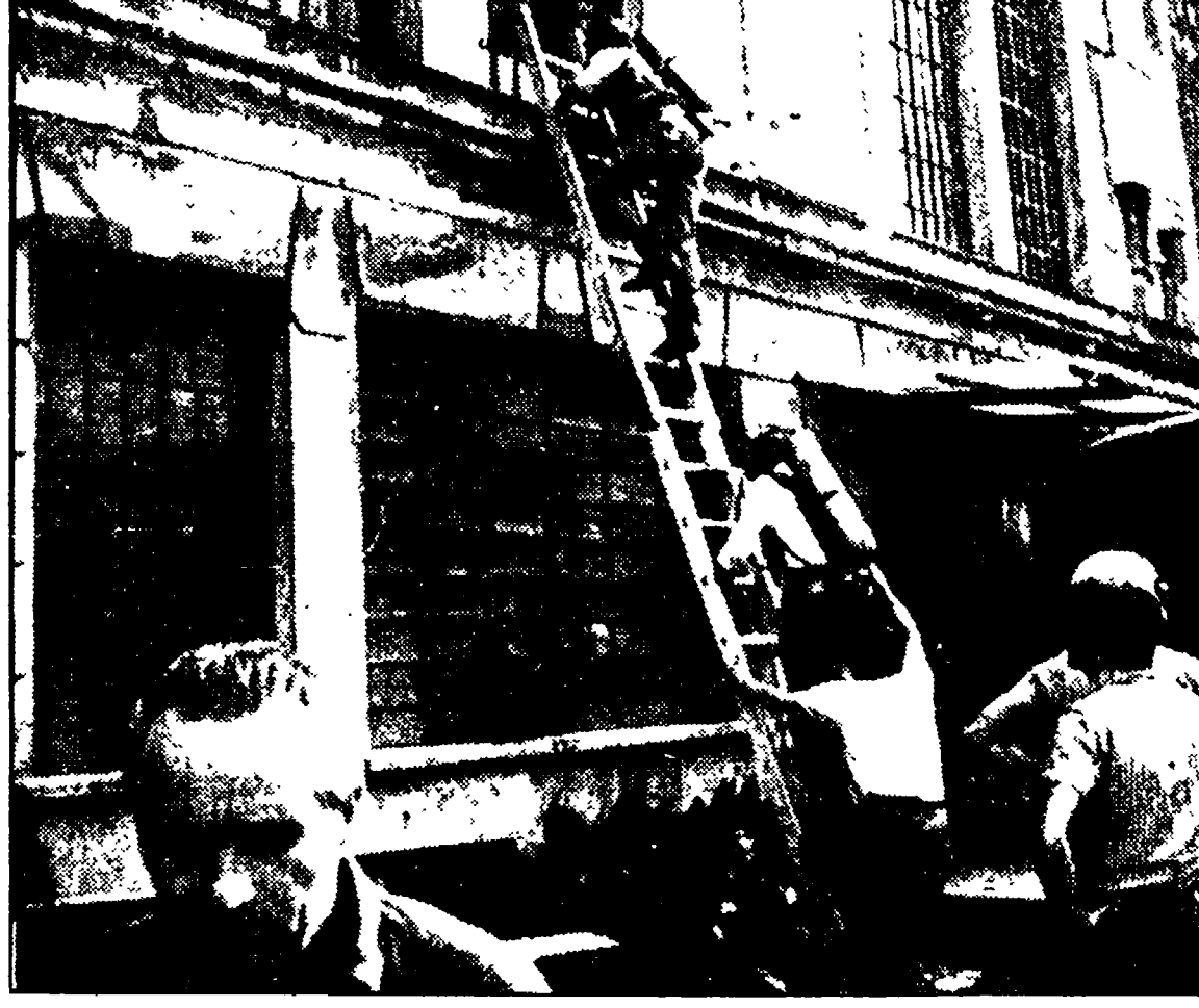
GENOVA — Squadre di vigili del fuoco in azione nello stabilimento Boccardo nel tentativo di portare soccorso agli operai rimasti all'interno dell'edificio
