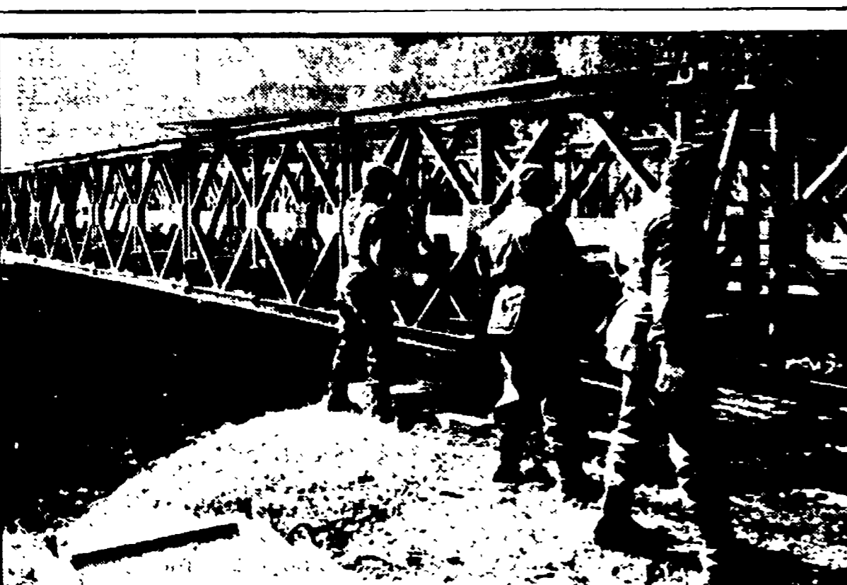
Un ponte in sette ore
