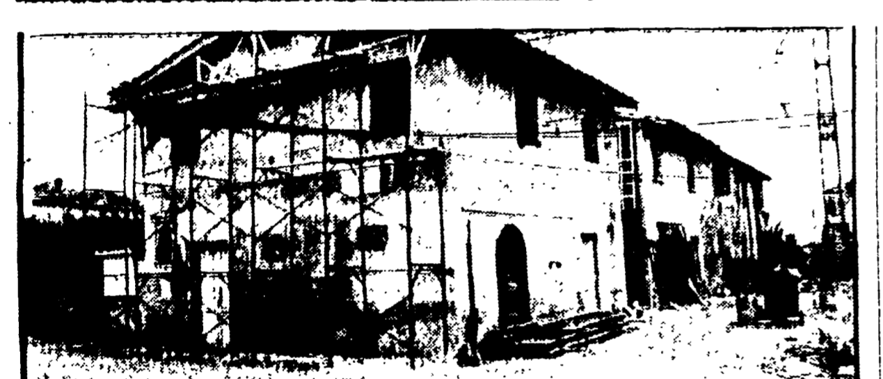
Gli ultimi lavori alla nuova Casa del Popolo di La Vettola
