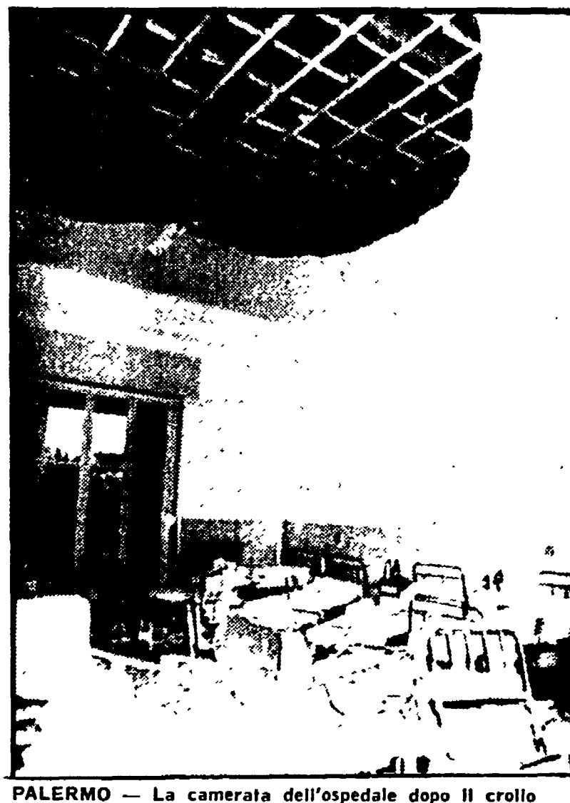
PALERMO — La camerata dell'ospedale dopo il crollo
