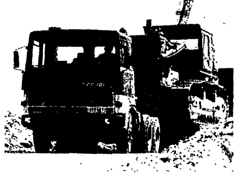
Un Berliet TRH 350 6x4 a lavoro in cantiere.
