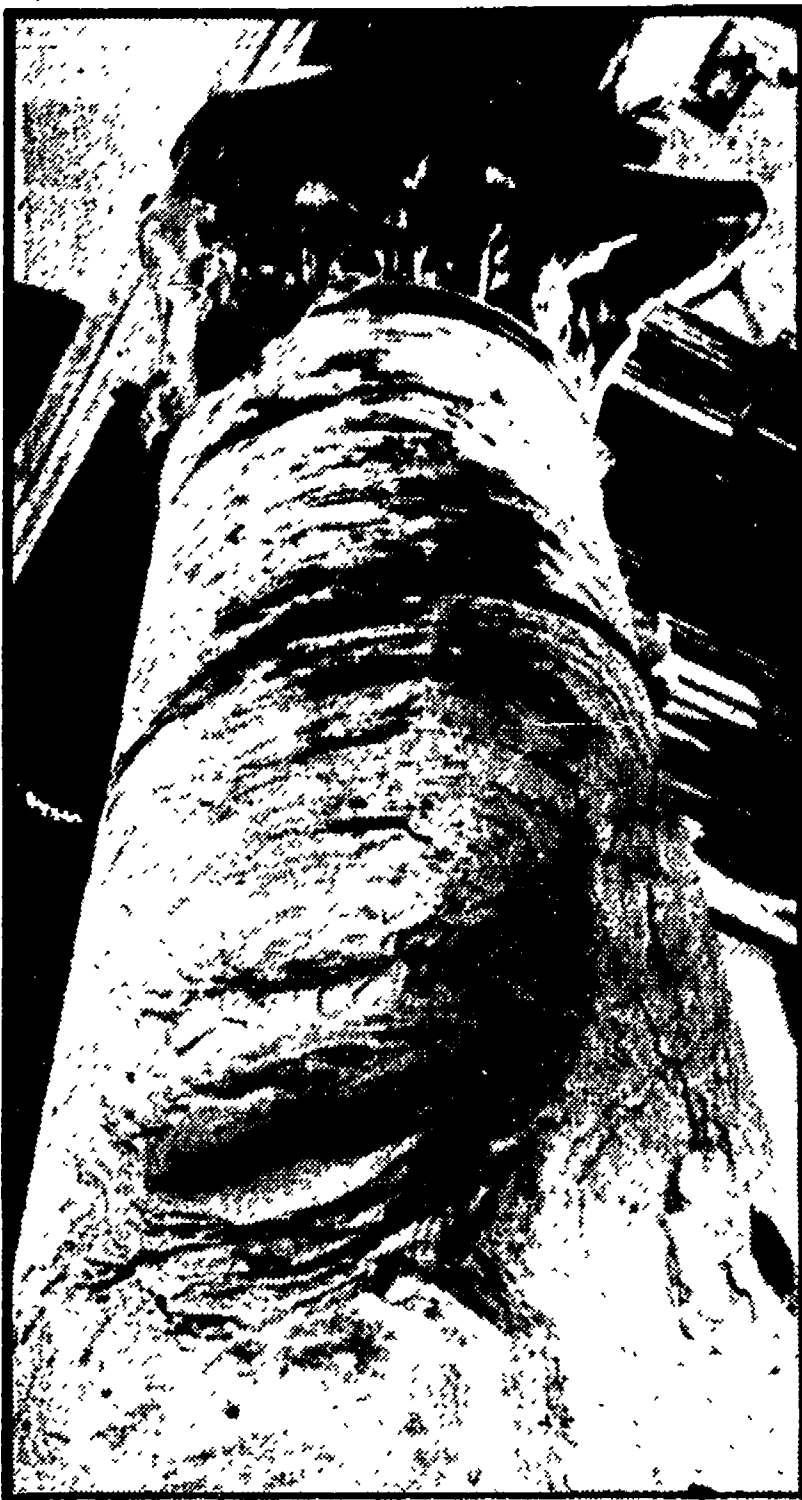
Un particolare del tempio di Antonino e Faustina al Foro Romano, che mostra evidenti segni del degrado
