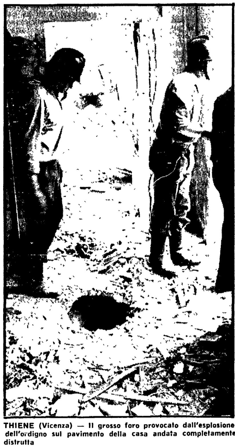
THIENE (Vicenza) - Il grosso foro provocato dall'esplosione dell'ordigno sul pavimento della casa andata completamente distrutta
