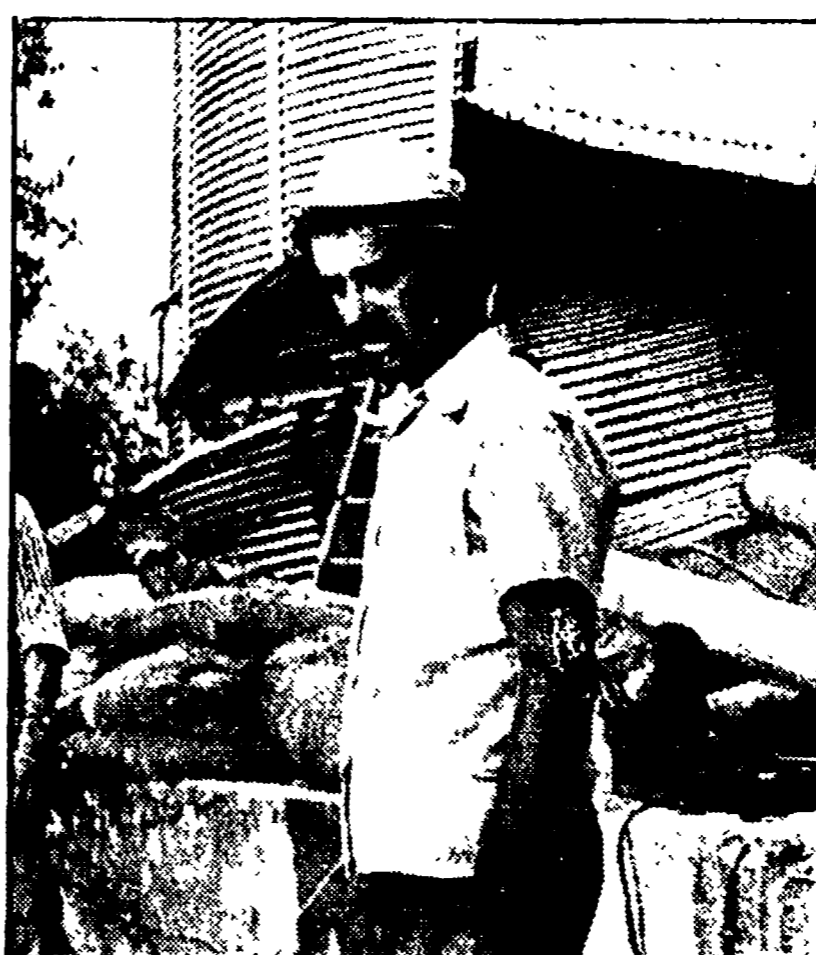
AMELIA — La costruzione di un silos della cooperativa
