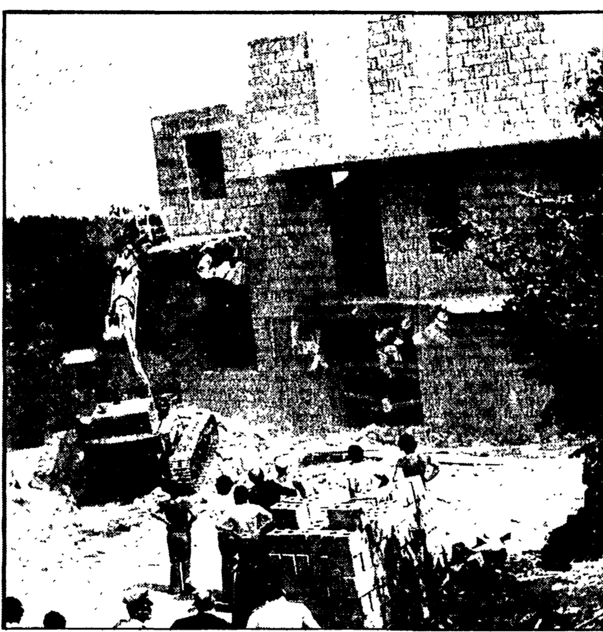
L'abbattimento di una costruzione abusiva in via Orsolona
