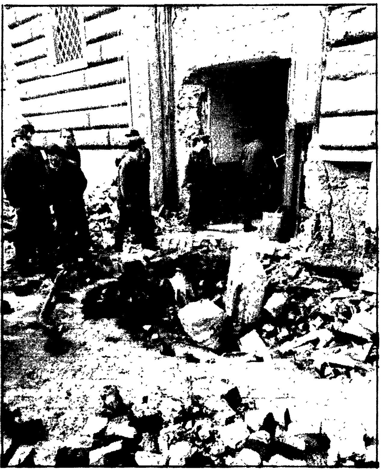
ROMA - Una immagine dei danni provocati dalla esplosione
