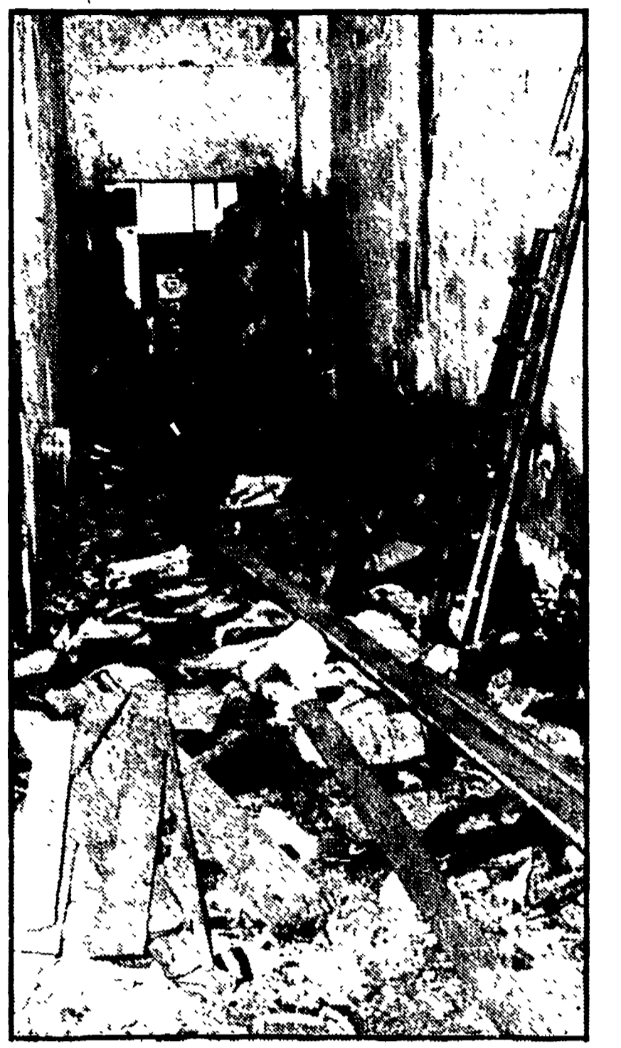
L'interno del liceo S. Francesco d'Assisi devastato dalle fiamme
