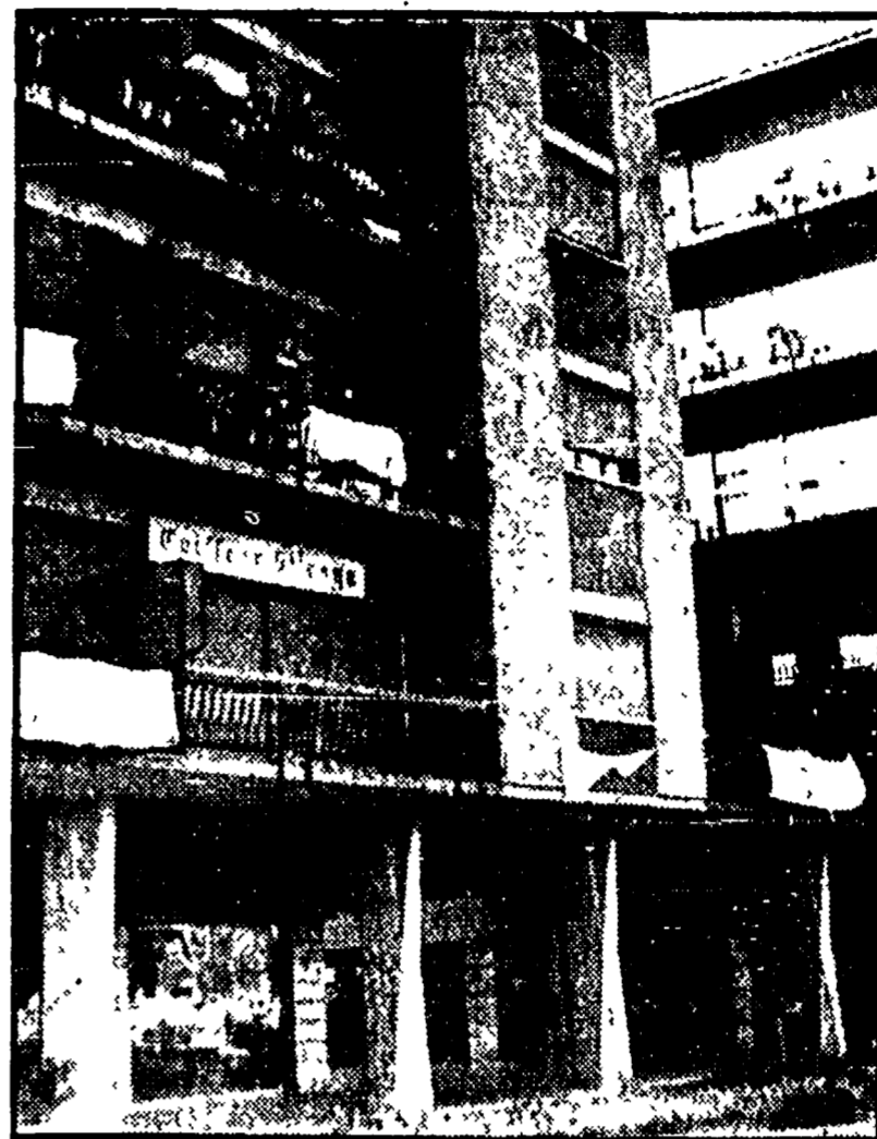
Il palazzo di piazza Sabino e (a destra) le condizioni di un interno
