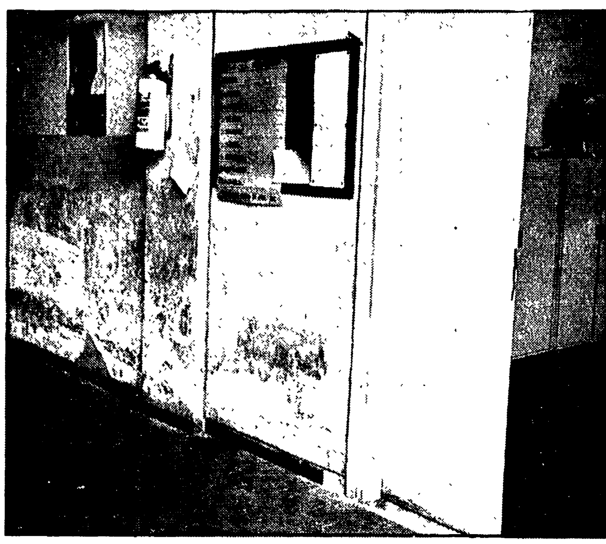
Il garage infestato dalle pulci al S. Camillo
