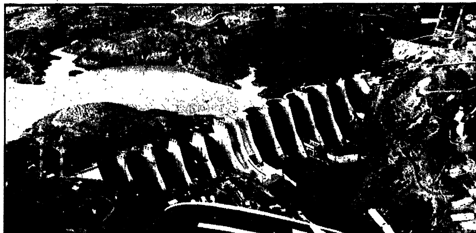
Un nuovo tipo di centrale idroelettrica ad Eraguane, in Algeria
