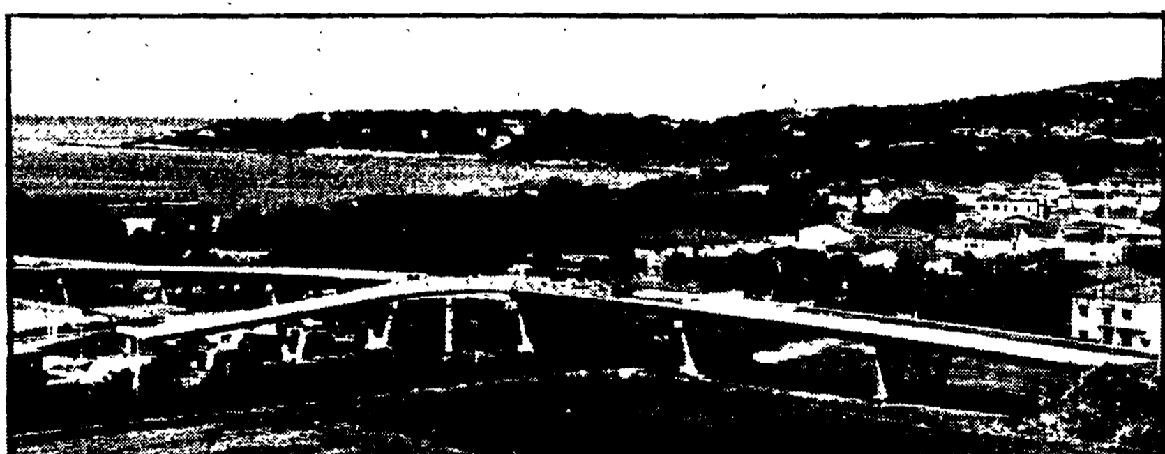
ROSIIGNANO SOLVAY — Il nuovo cavalcavia ferroviario
