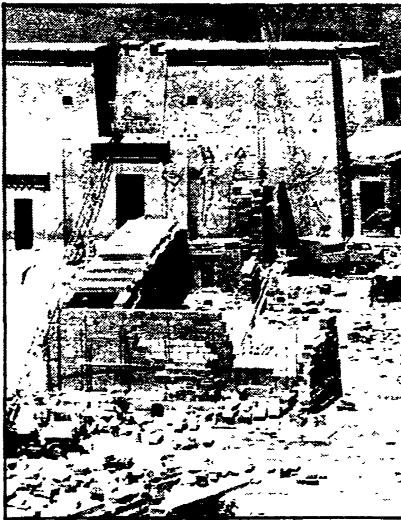
I monumenti di File ricostruiti sull'isola di Agilkia. In alto, il cantiere di stoccaggio dei blocchi del tempio
